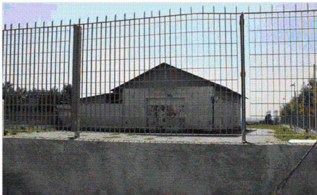
Fig. 13 - Il capannone del deposito CEMERAD
