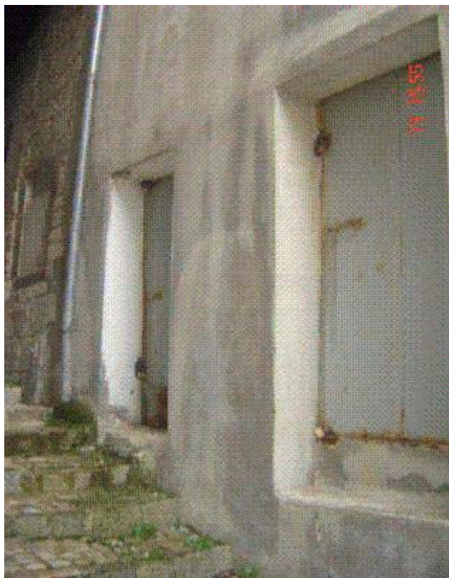
Fig. 11 – Gli ingressi dei locali satelliti del deposito CANRC
