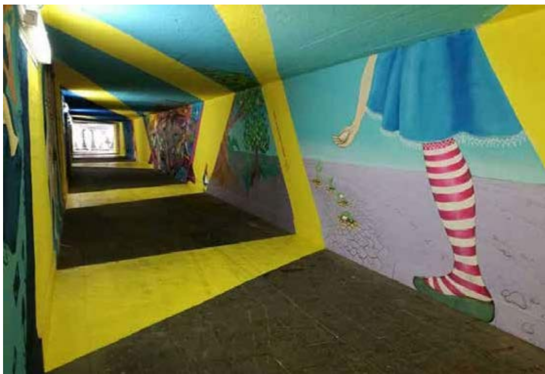
Sottopasso di Crescenzano dopo l'intervento di riqualifica
