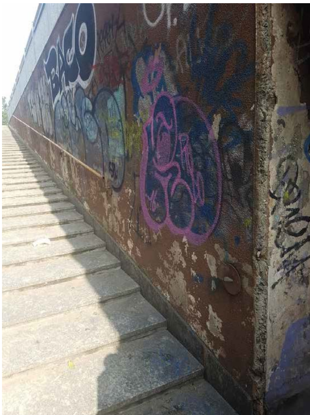
Sottopasso di Crescenzano prima dell'intervento di riqualifica
