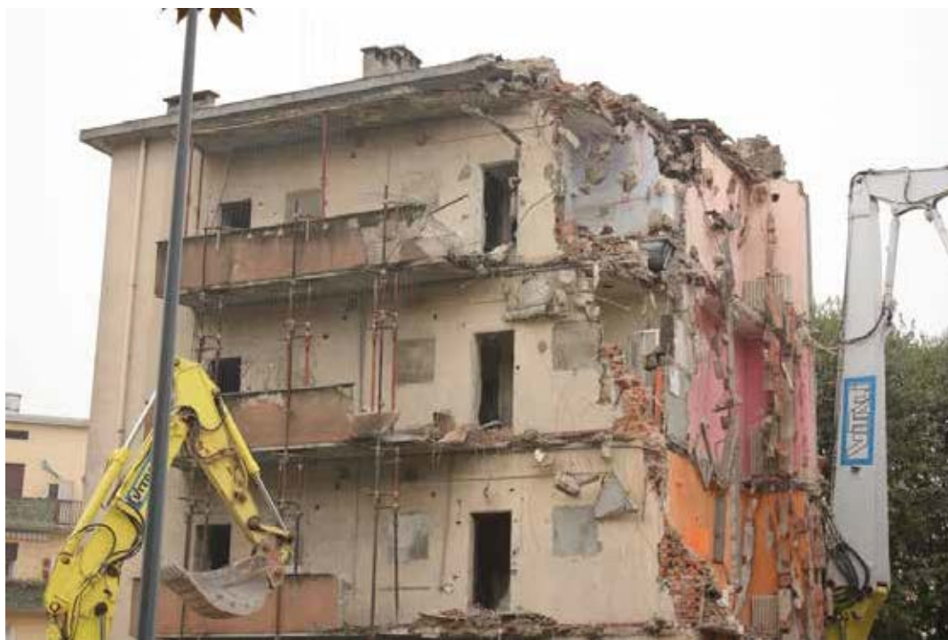
Giambellino - Lorenteggio (demolizione)
