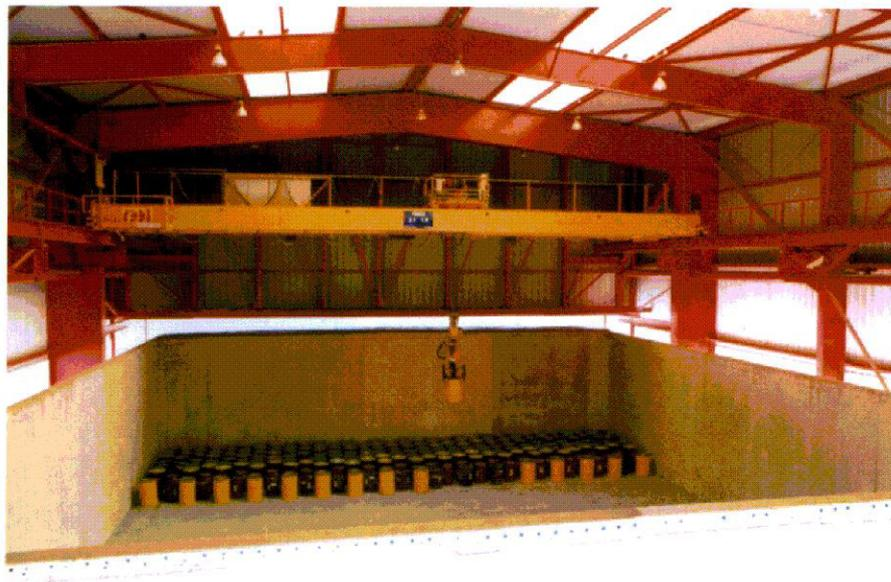
Figura 5 – Caricamento di una cella nel deposito de l'Aube.
