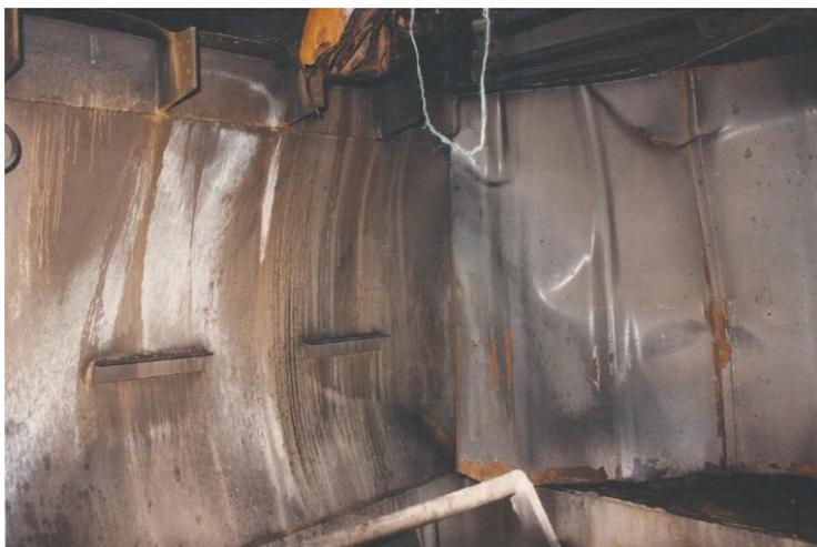
Immagine 4: bombatura delle paratie con cedimento lungo la saldatura e completa assenza di segni da proiezione di schegge/ frammenti
