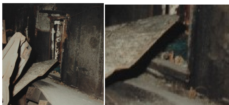
Immagine 28: porta sul ponte garage con mastra inferiore
