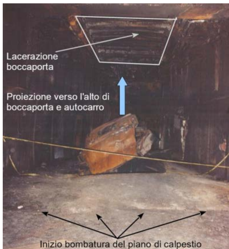
Figura 10: Vista dal garage del traghetto della boccaporta del locale eliche di prua divelta ed autocarro deformato
