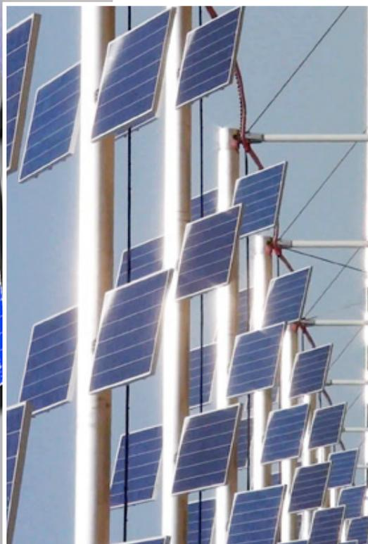
L'inseguitore solare sospeso è una struttura meccanica rotante a sviluppo orizzontale atta alla movimentazione di pannelli fotovoltaici.
